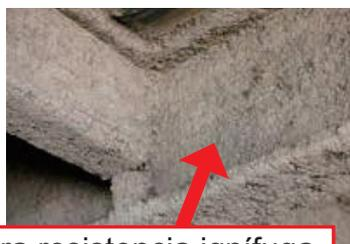
Para resistencia ignífuga de estructuras de acero
