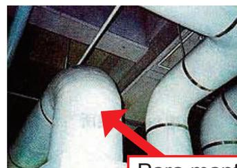
Para mantener la temperatura caliente en cañerías
