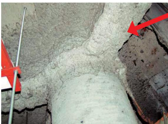
Utilizado para dar resistencia al fuego en estructuras de acero
